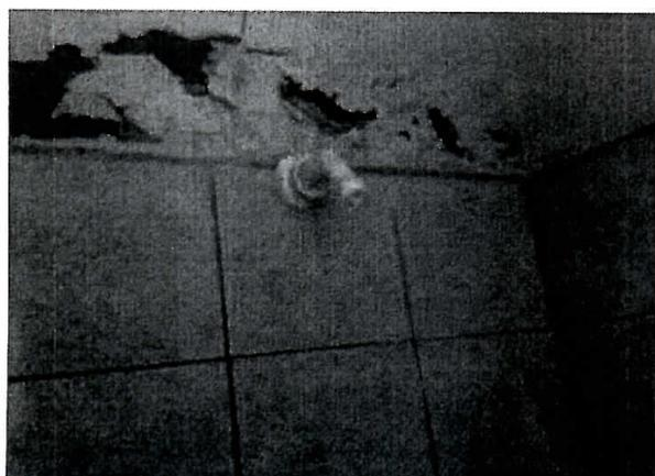
Se observa descascaramiento de los muros y la falta del rociador de la ducha.
